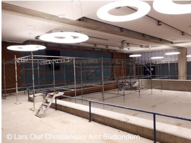
Baumaßnahmen an der Stadthalle
